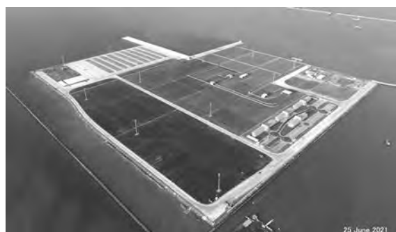
写真一 1 パッケージ1 完成写真
