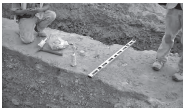
写真一6 止水壁頭部の出来型検査
