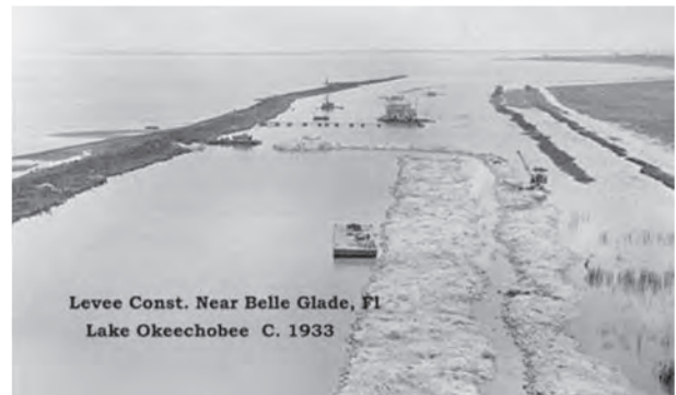
写真一2 1933 年頃の HHD 初期築堤状況
