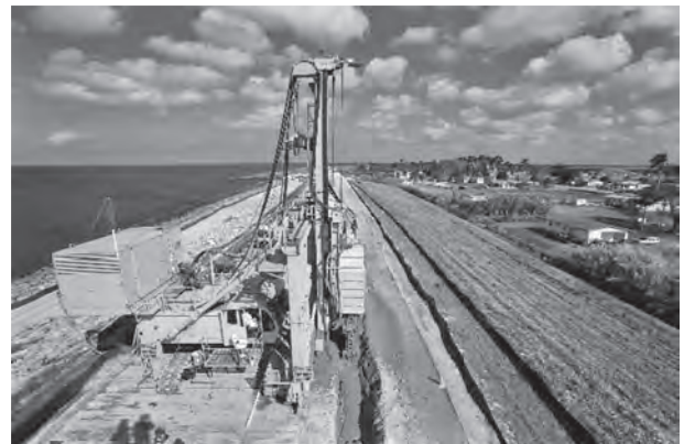
写真一 3 本工法施工状況 ①
