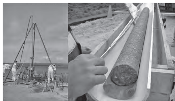
写真一7 コアボーリング採取状況
