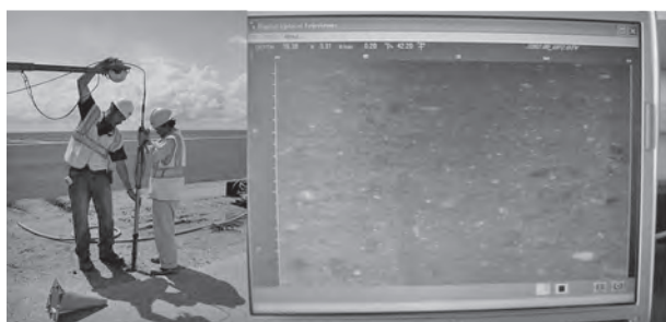
写真一5 ダウンホールカメラによる壁内ビジュアル検査
