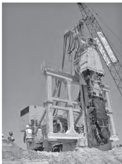
写真—1 本工法機
