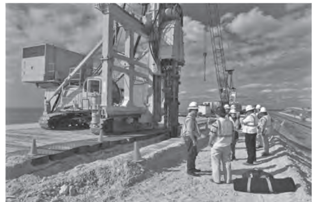
写真一 4 本工法施工状況 ②
