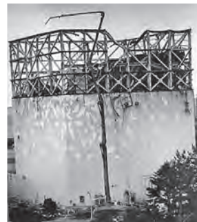
写真一13 原発の冷却放水
