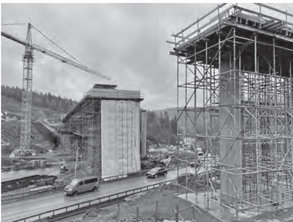
写真—4 既存の道路をまたぐ高架橋の建設の様子。写真：TUM スタジオ
