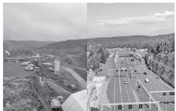
写真—2 実際の現場の様子（左）と Trimble Connect 上で表示される 3D モデル
