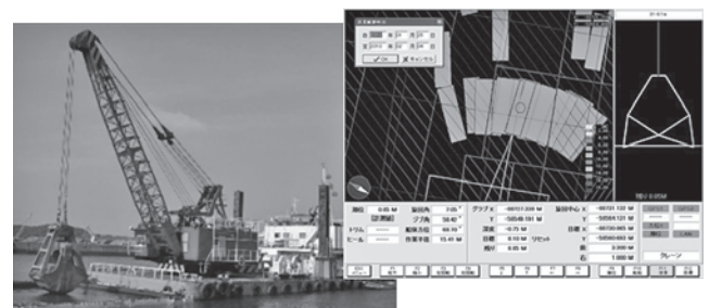
図一-3 ICT浚渫工（施工の可視化）
