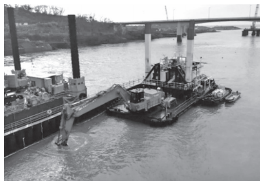
写真-2 バックホウ浚渫船の掘削状況
