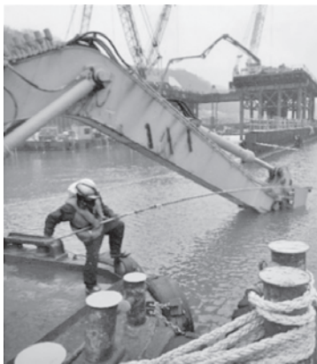
写真一4 レッド測量 (従来の方法)
