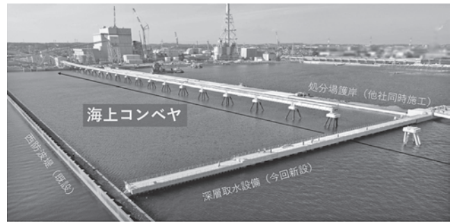
写真-2 海上コンベヤ基礎
