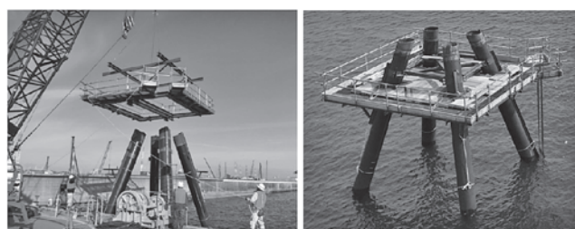
写真-10 足場設置状況
