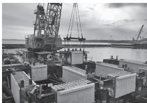
写真-8 PCa 梁設置状況
