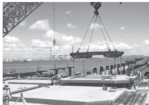
写真-9 PCa スラブ設置状況
