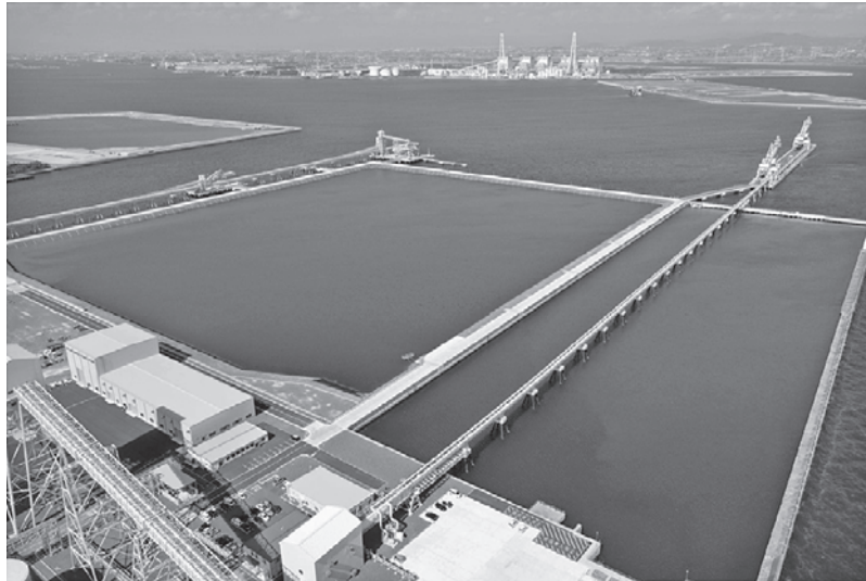
写真-14 工事完了写真
