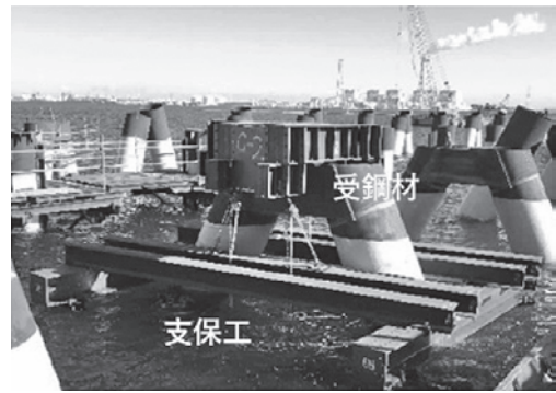
写真-4 受鋼材、支保工、PCa梁架設状況
