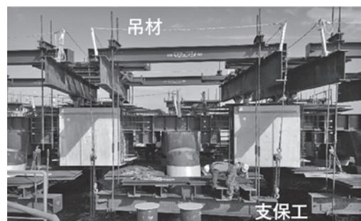
写真-6 吊支保工状況
