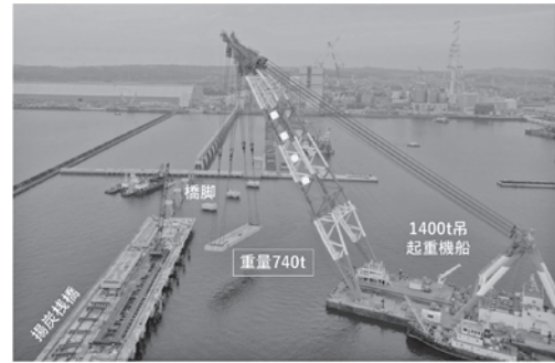
写真-13 海上通路橋の一括架設状況
