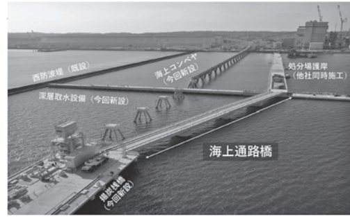
写真-12 海上通路橋全景
