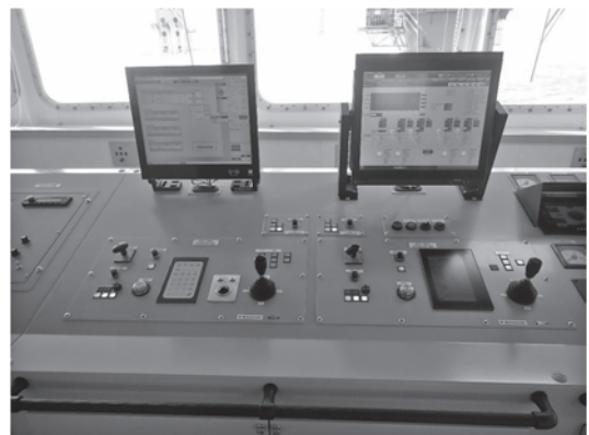
写真-6 DPS操作盤
