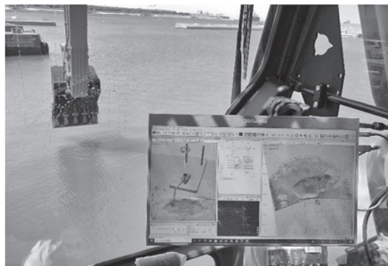
写真1 MBES施工管理システム使用状況 台船：ハヤカワ建設機一栄号
