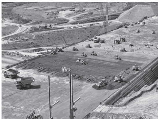
写真—2 A 4 CSEL による施工状況
