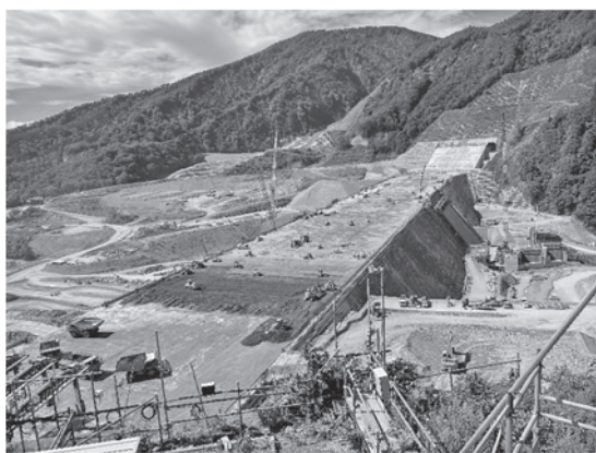
写真—1 現場全景（左岸側から望む）
