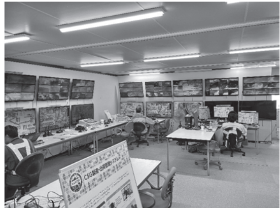
写真—8 CSG 中央制御室
