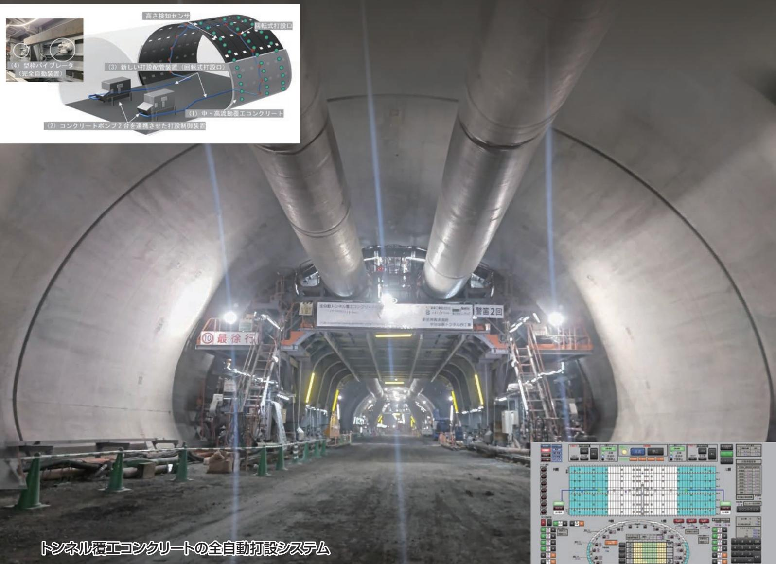
トンネル覆工コンクリートの全自動打設システム
