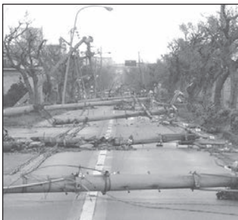
&lt;電柱の倒壊による道路閉塞&gt;
