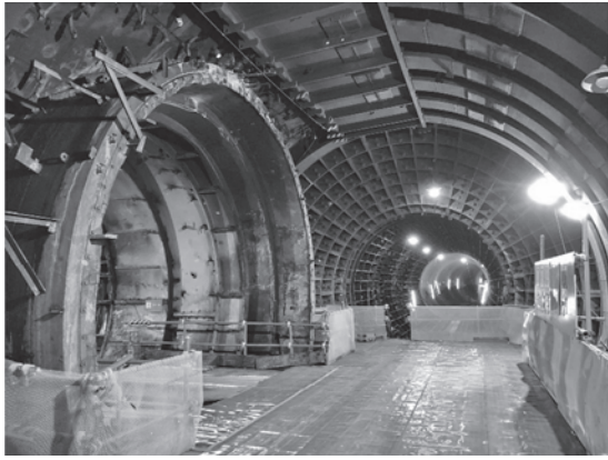
写真—4 隅田川幹線その3工事完了時
