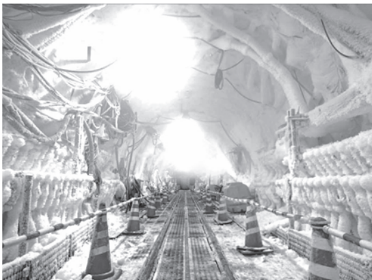
写真一1 凍土造成時のトンネル坑内
