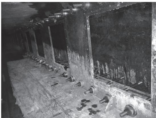
写真一5 閉合部棒状連結材設置状況
