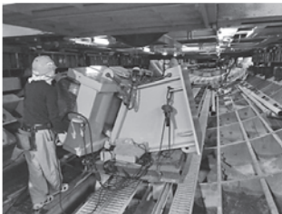
写真一14 車輪引込状況②
