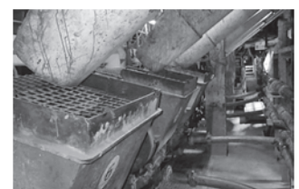
写真-3 打設ポンプ
