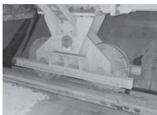
③下部コンクリート区間車輪
