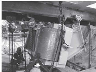
写真一15 車輪設置状況①
