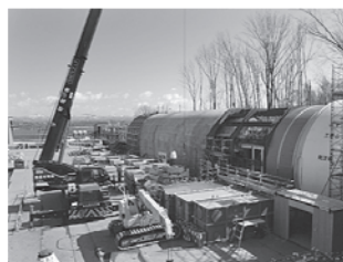
写真一〇 投入開口状況
