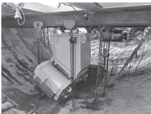
写真一16 車輪設置状況②
