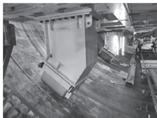
写真一17 車輪設置完了
