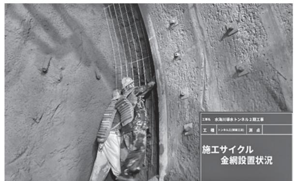
写真-10 溶接金網設置状況 (従来工法)
