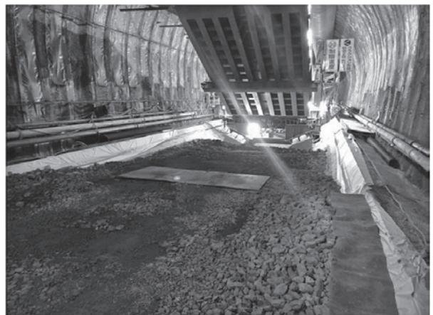
写真-7 インバート栈橋(跳ね上げ時)
