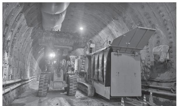
写真—4 掘削ずり投入状況
