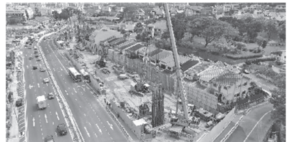
写真-4 地下連続壁施工状況
