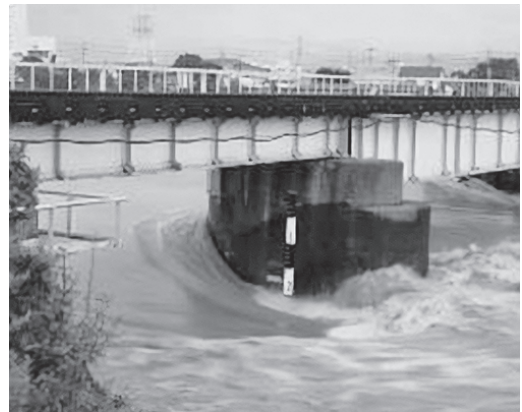
図-1 増水した河川に架かる橋梁
