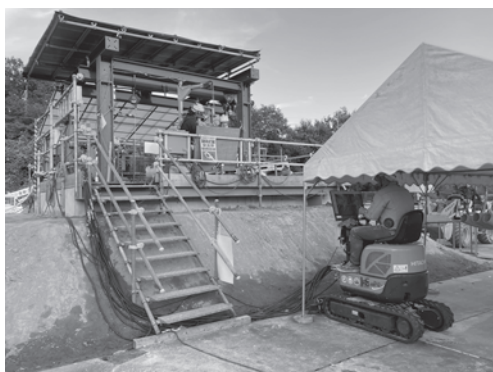
写真—2 坑外からの遠隔操作
