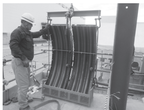
写真—3 ライナープレート運搬台車
