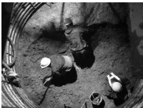
写真—1 人力による掘削状況
