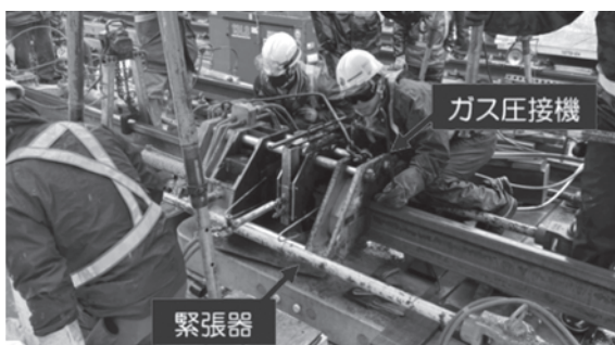
写真—5 緊張器を使用したガス圧接
