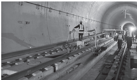
写真一3 レール扛上時
