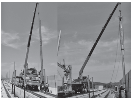
写真一六 特種車ⅢEによる電車線柱建植（左：最大の電車線柱建植、右：複線の反対側への建植）
