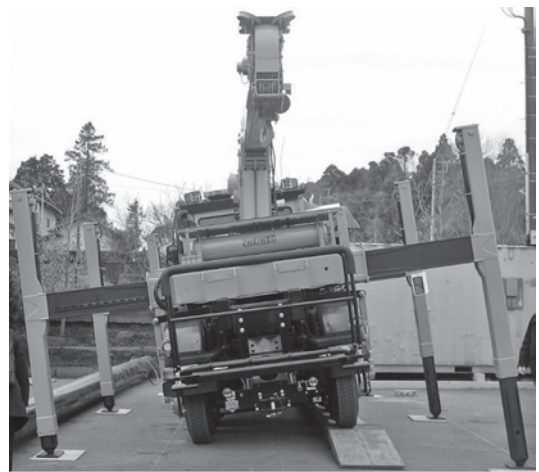
写真-3 カント補正機能によるクレーン水平調整
