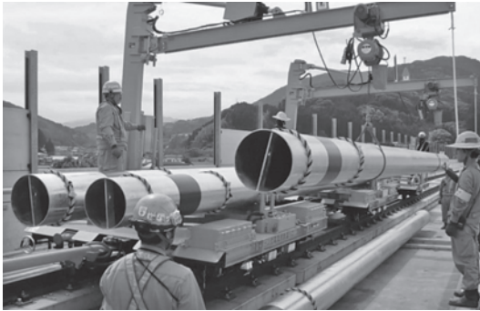
写真一4 D型トロによる電車線柱の荷卸し
