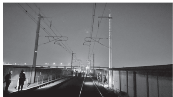
写真-10 施工完了
