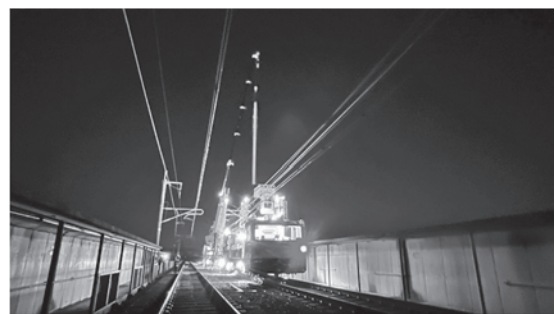
写真-9 ステップ3-② 鋼管柱新設
