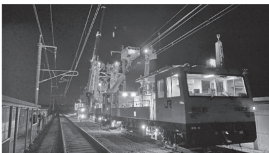
写真-7 ステップ1-③ 架線支持外し
