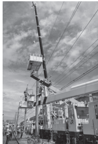
写真一 6 施工訓練
