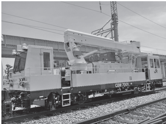
写真—2 電柱用高所作業車
