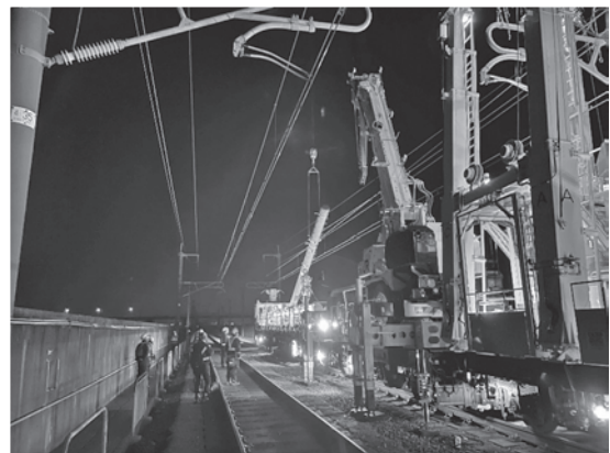
写真-8 ステップ2-① コンクリート製電柱撤去
