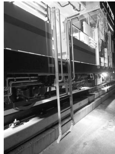
写真一九 伸縮昇降梯子
