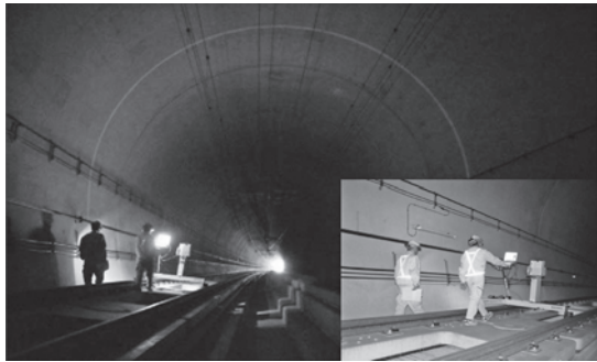
図-3 3次元レーザーによる鉄道施設の確認
