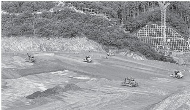
写真1 自動建機4台の施工状況
