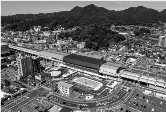
写真一八 武雄温泉駅周辺整備状況（南側）
