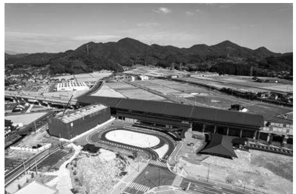
写真—7 嬉野温泉駅周辺整備状況 （写真手前が新幹線開業と同時にオープンした道の駅）
