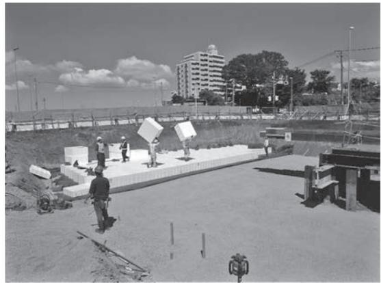
写真-3 軽量盛土施工状況
