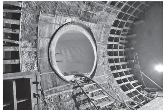
写真—8 接合部二次覆工完了
