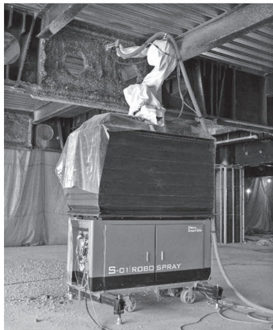
図-7 耐火被覆吹付けロボット
