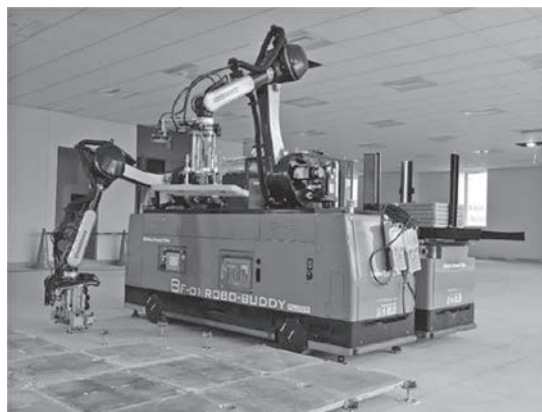
図-8 OAフロア施工ロボット
