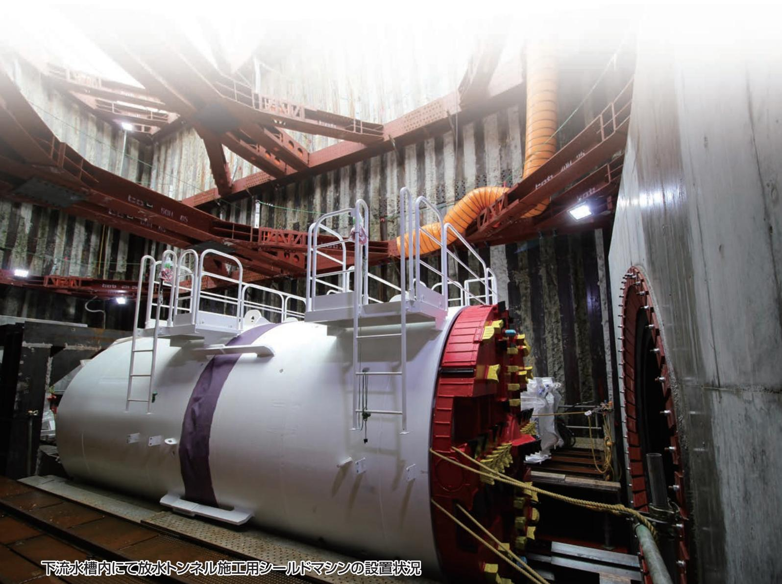
下水水槽内にて放水トンネル施工用シールドマシンの設置状況
