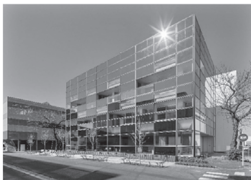
図-4 技術センターに建設された「ZEB」
