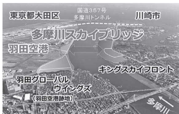
図-1 多摩川スカイブリッジ
