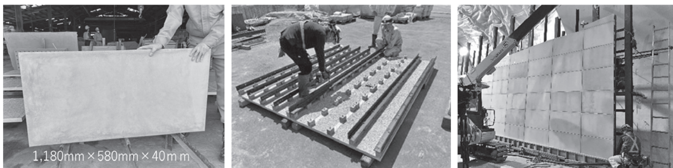
図一8 CUCO-SUICOM 型枠の施工状況
