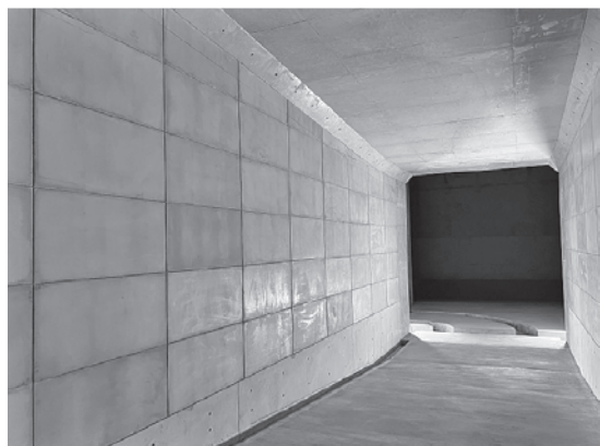
図一9 CUCO-SUICOM 型枠の施工後の状況
