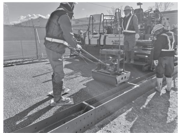
写真-2 ポーラスコンクリート試験施工状況（2023年12月）
