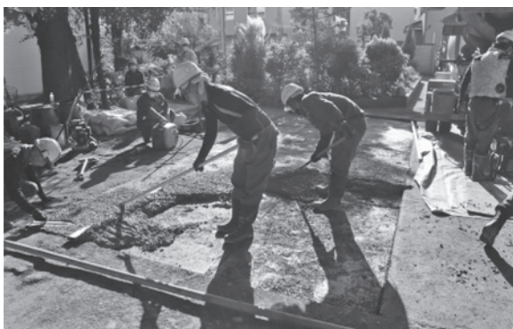
写真-1 CPコンクリート試験施工状況（2022年8月）
