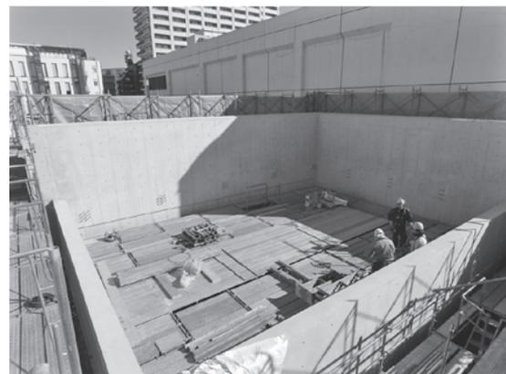
写真-2 地上躯体壁の型枠取り外し後の状況
