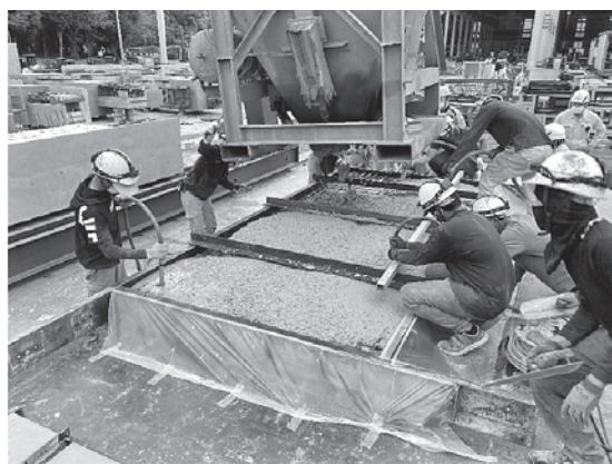
写真-7 打込み状況 (その2)
