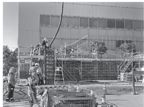
写真一1 地上構造物への打込み状況
