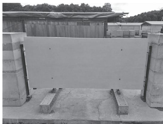
写真-8 脱型後の状況 (その2)
