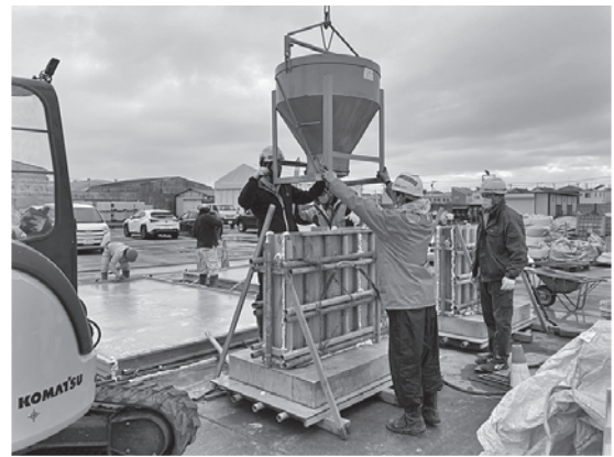
写真-5 打込み状況（その1）
