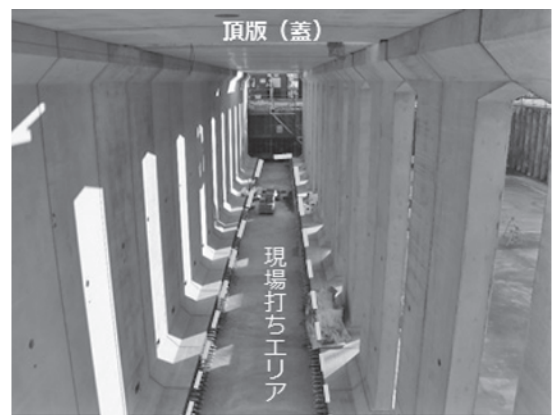
写真—1 上流水槽の構築作業
