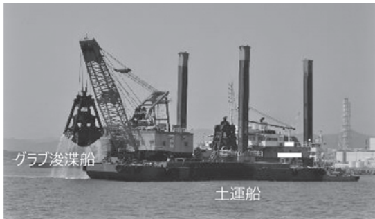
写真—5 海底掘削作業
