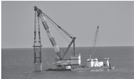
写真—6 ケーソン据付作業
