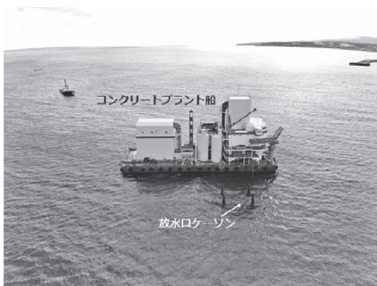
写真—7 ケーソン埋戻し作業
