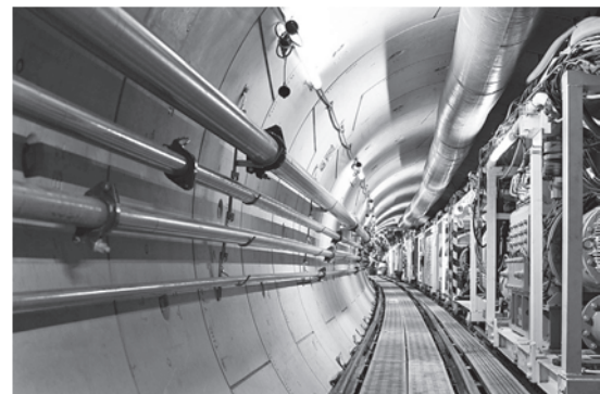
写真—4 トンネル内部
