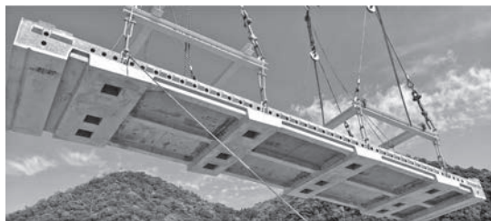
写真-4 床版吊上げ
