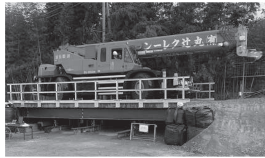
写真-2 車両載荷試験
