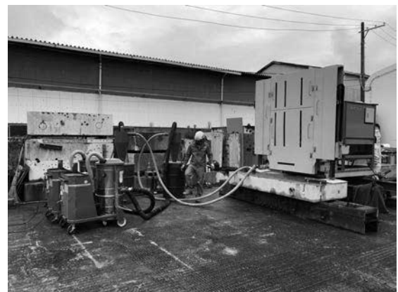
写真一5 乾式切断 機材配置と切断作業状況
