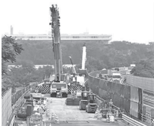
写真—1 床版取替工事の事例
