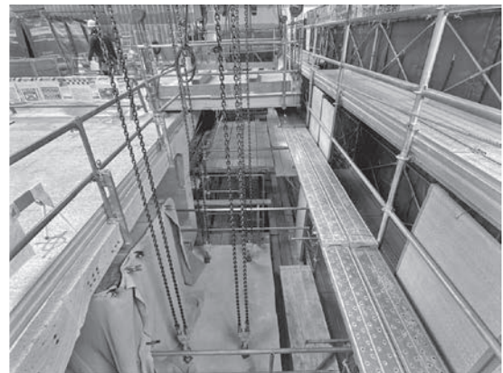
写真一6 撤去ブロック仮吊切断状況
