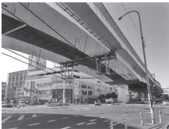
写真-1 架け替え前の喜連瓜破高架橋
