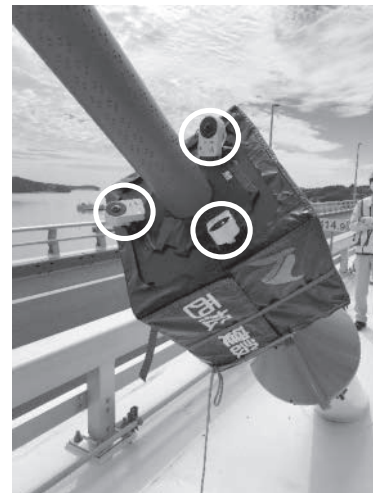
写真一3 外部カメラ (○印)
