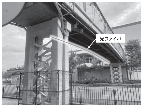
図-5 ひび割れ検知対象の歩道橋
