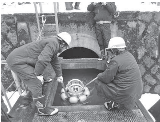
図一四 東北地方太平洋沖地震発生後の水道水路トンネル調査
