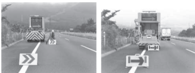
図一七 矢印板設置作業の違い
