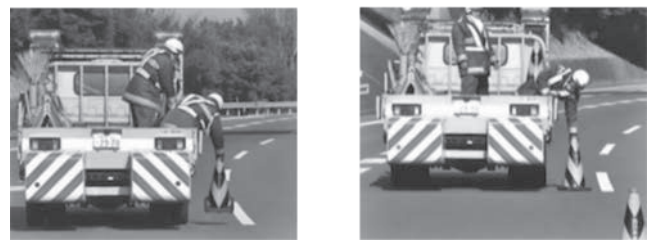
図一2 ラバーコーン設置・回収作業
