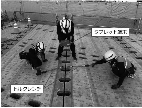
図-3 締付ボルトのトルク管理
