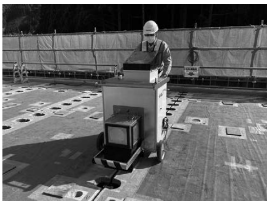
写真—2 計測状況 (出来形検査システム)
