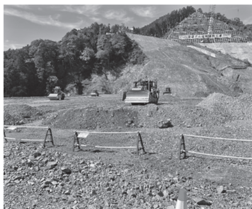
写真一 自動建機による施工状況
