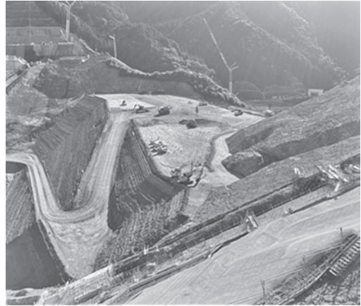
写真一5 堤体と上流側工事用道路
