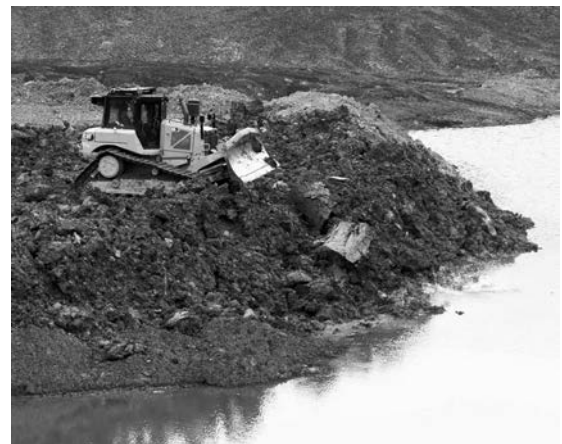
写真-6 転落リスクがある作業での遠隔作業
