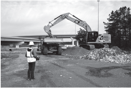
写真一 2 コンソールシステム
