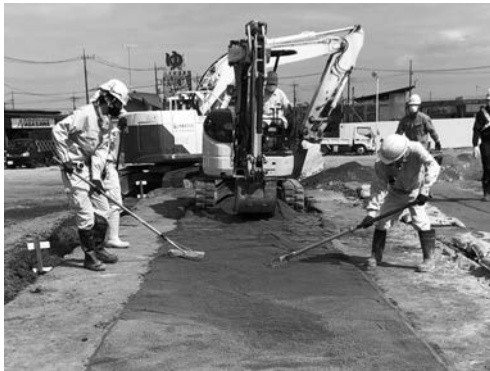
写真一 3 溶融スラグ敷均し状況
