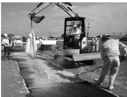
写真一 5 固化材敷均し状況
