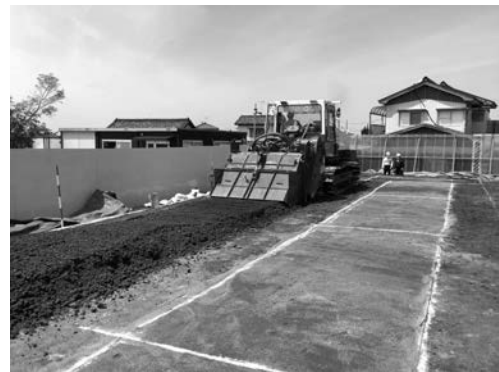
写真一 6 混合攪拌状況
