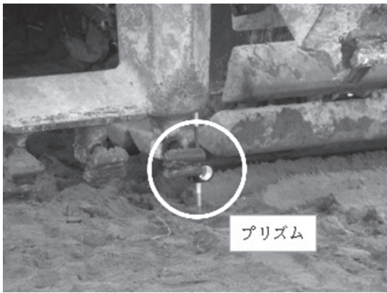
図-5 測量機でプリズムの位置を測量
